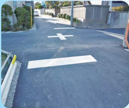
地域の方の協力で緊急車両も通行可能に (元茂田井保育所付近)
